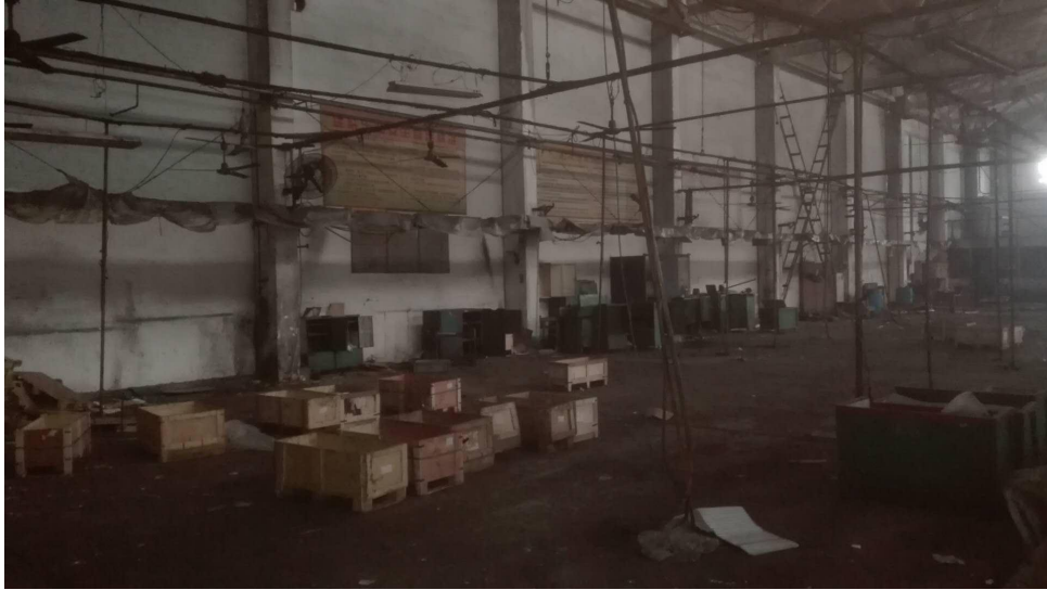
生产车间内部
